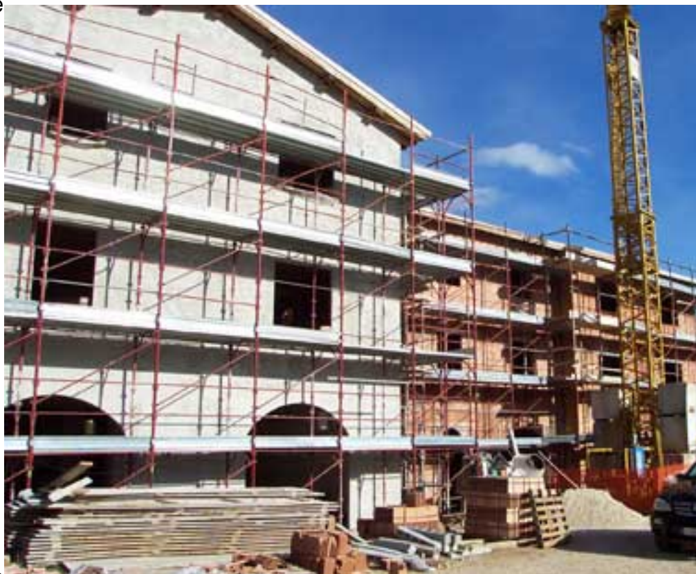
intervento in fase di realizzazione
