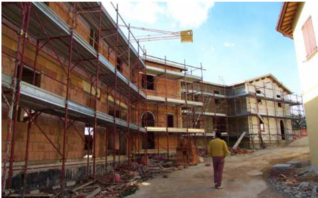
fase finale di realizzazione
