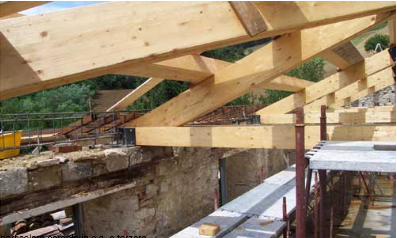
particolare cordolo in c.a. e terzere
