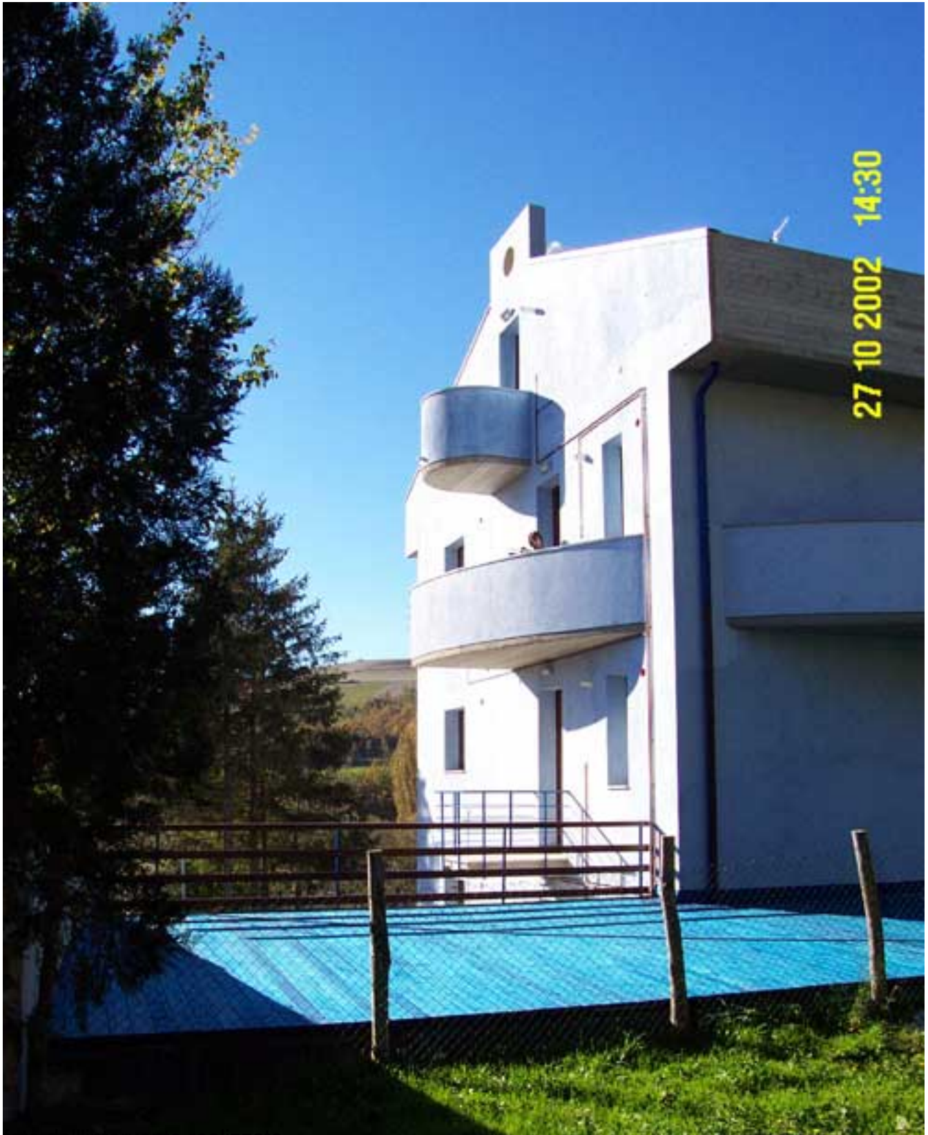
Foto dell'intervento realizzato
