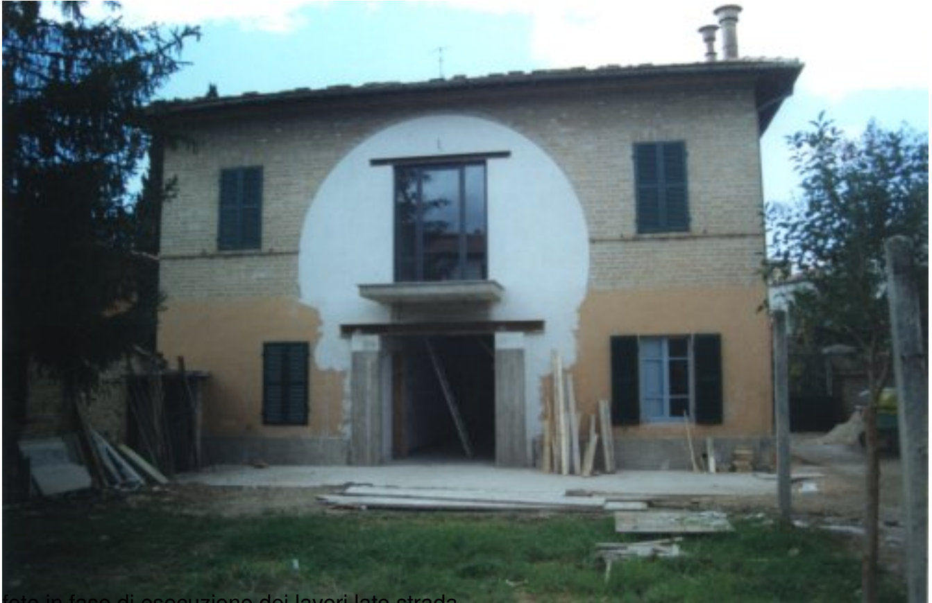
foto in fase di esecuzione dei lavori lato strada
