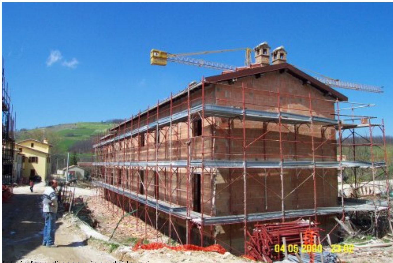
foto in fase di esecuzione dei lavori
